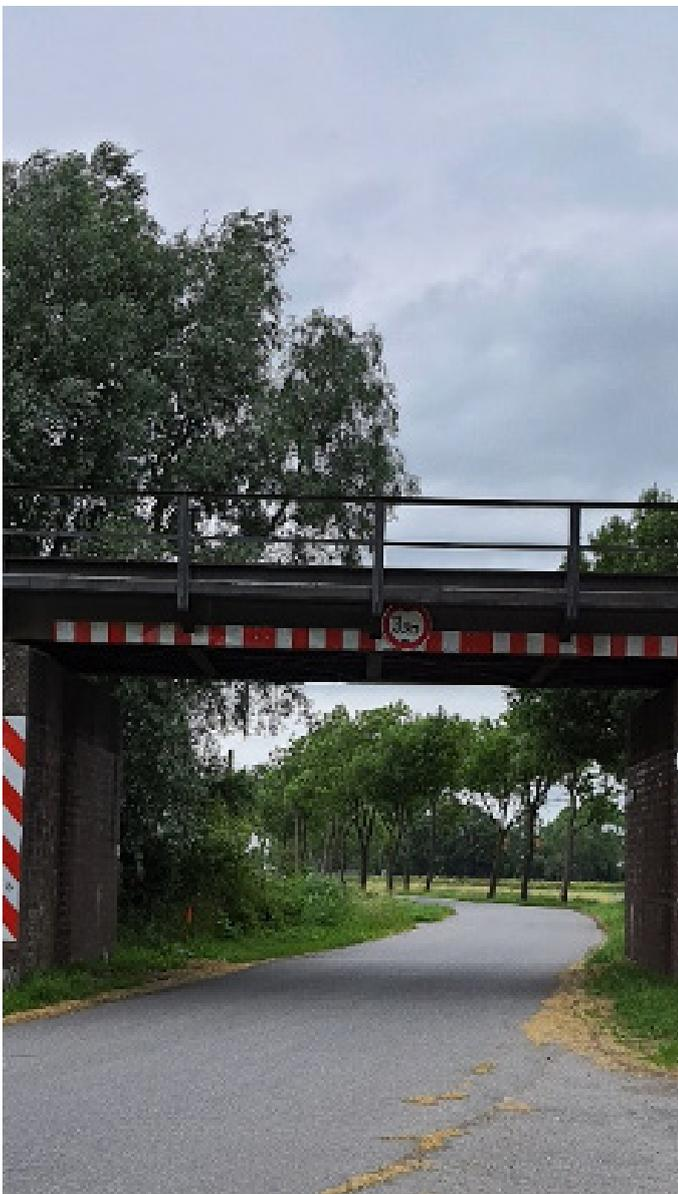
EÜ Hilkenborger Straße wird durch neue Widerlager und einen Stahltrög-Überbau komplett ersetzt (Quelle: DB Netz AG/Stefan Wey)
