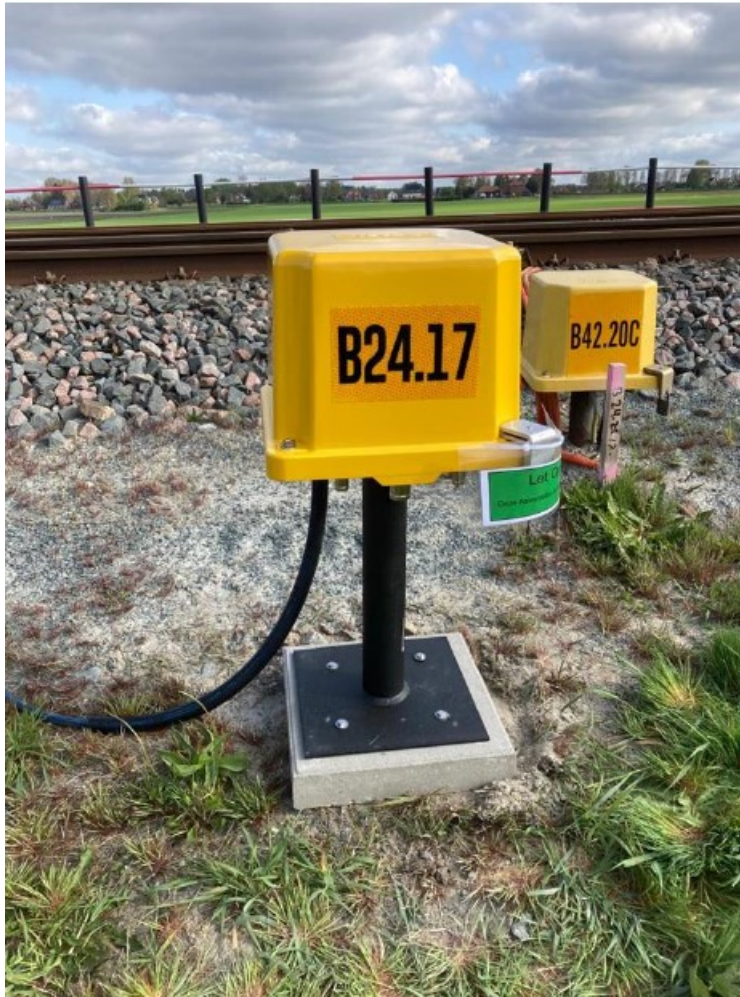
Met een groene label is herkenbaar dat de assenteller niet indienst is.
